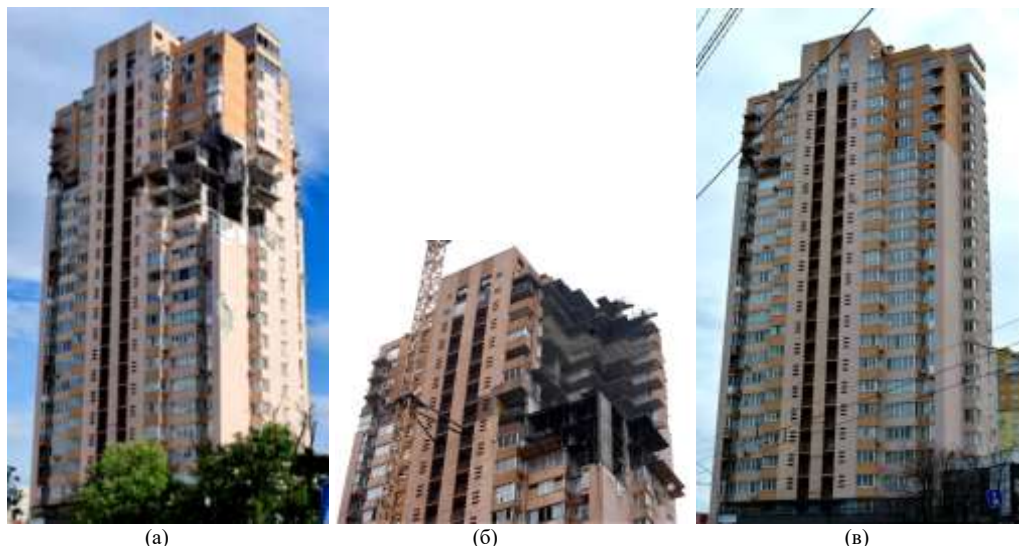
Рис. 6. Каркасно-монолітний житловий будинок, м. Київ: а – руйнування від влучання російської ракети 26 лютого 2022 р.; б – демонтаж конструкцій 17...26 поверхів; в – відновлений будинок
