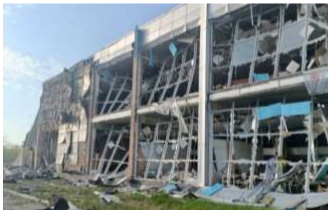
Рис. 3. Руйнування вітражів каркасної будівлі торговельного центру в результаті російських ракетних обстрілів, м. Миколаїв, 16 травня 2023 р.
