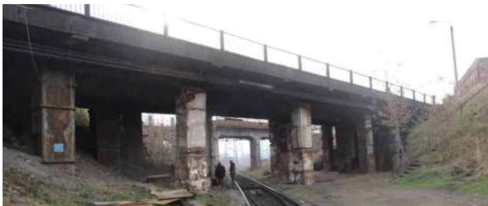
Рис. 1. Загальний вигляд стану шляхопроводу на період обстеження [4]
