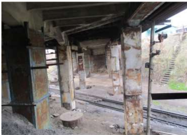
Рис. 2. Стан несучих конструкцій шляхопроводу на перетині з залізницею на період обстеження [4]
