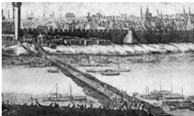
Рис. 2. Приклад дерев'яного наплавного мосту в Середні віки [3]
