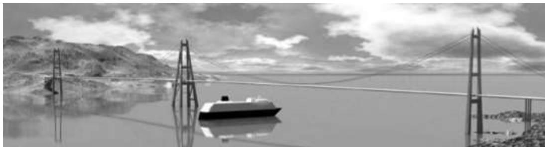
Рис. 17. Візуалізація наплавного мосту з використанням технології TLP через Хальсафіорд [5]
