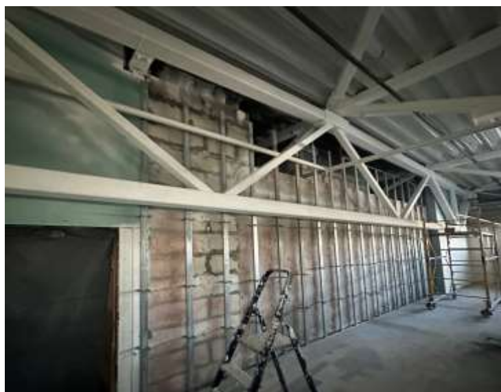
Рис. 6. Відновлена частина ферми та покриття
