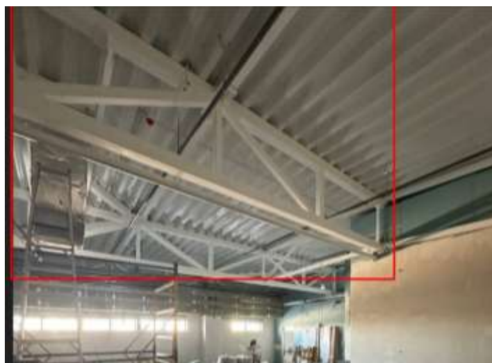
Рис. 7. Відновлена частина покриття з обладнанням
