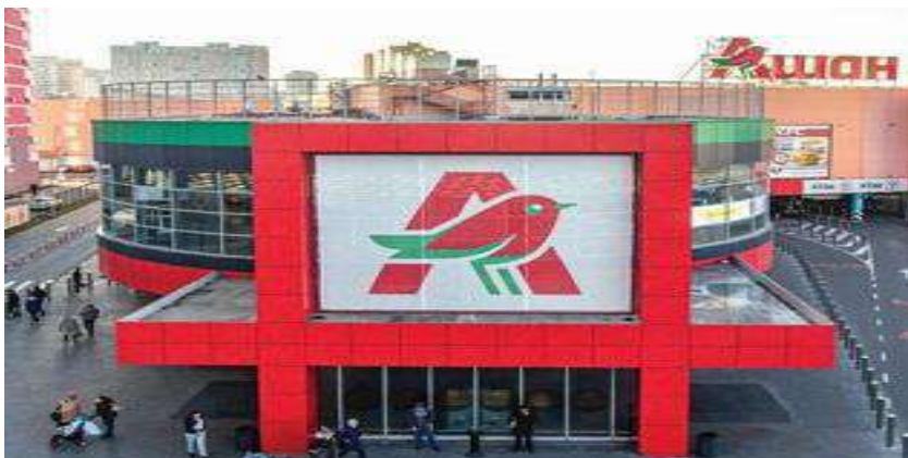
Рис. 1. Загальний вигляд торгово-розважального комплексу
