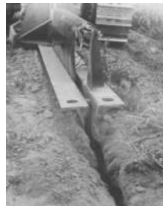
Рис. 8. Укладання рулонної плівки в основі земляної дамби
