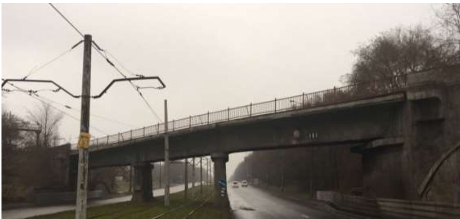
Рис. 3. Загальний вигляд шляхопроводу [1]
