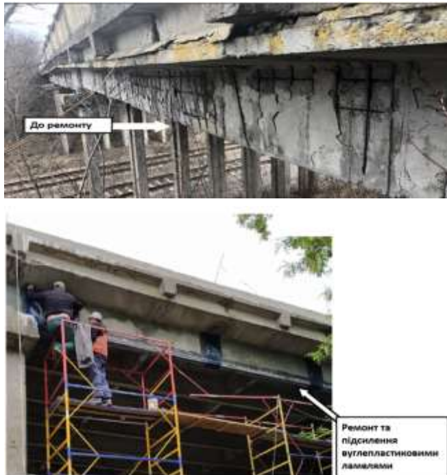
Рис. 1. Ремонт та підсилення прогонових будов шляхопроводу на км 219+400 а/д М-13 Кіровоград-Платаново. (фото: Т.Л. Чирва, ООО «Придніпров'я»)
